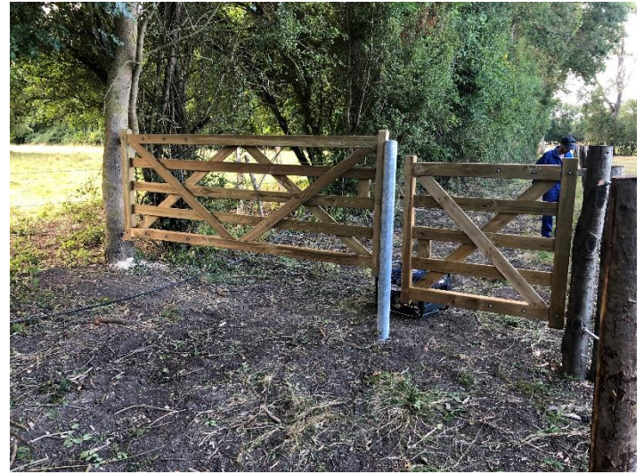
Pose d'un portail le long de la Va6 (zone des Dureaux)
